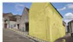
* Vue de la rue Guilbert-Latour en jaune bâtiment à démolir
